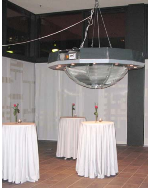
Abb. 1. Offenes System zur Raucherfassung über den Rauchenden.
